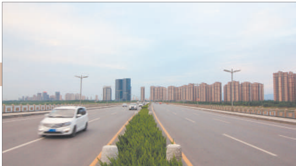
伊河大桥望新城 (武鹏鹏)
