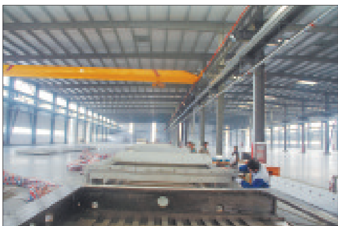
兰迪玻璃正在进行设备安装
