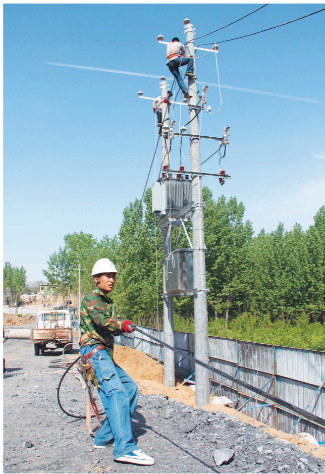
南环路雷村段施工用线路正在紧张铺设中 杨万通 摄
