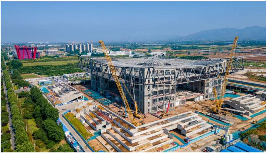
近日,洛阳科学中心项目最后一根封边钢桁架吊装完毕。施工的顺利完成是项目继五层楼面钢桁架提升后的又一重大突破,标志着项目钢结构重难点工程全部完成。
