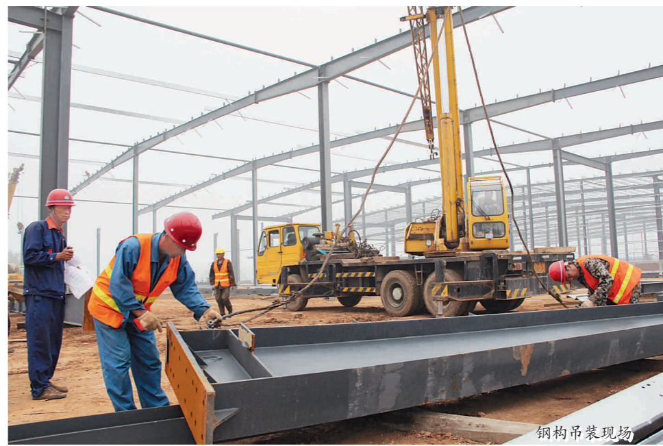
钢构吊装现场
