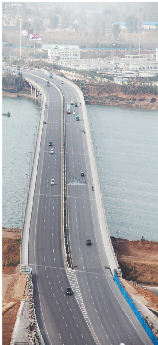
建成的伊洛大道跨伊河桥水马龙,已经成为我区的重要交通枢纽。
