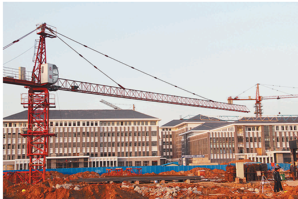
洛阳师范学院一期教学楼、学生公寓B1区封顶。
