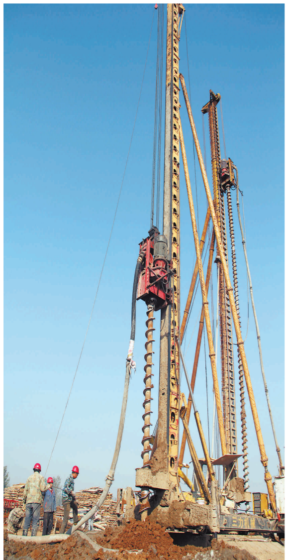
洛阳师范学院一期宿舍公寓B2-B6区正打桩灌混凝土。
