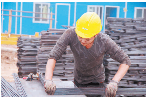
10月6日,4号安置小区建筑工人加班加点赶工期。苗蔚 摄
