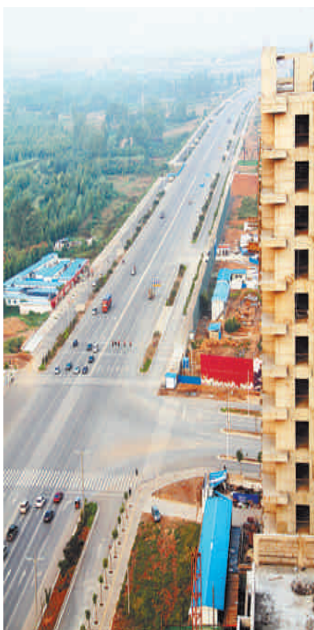
洛偃快速通道伊滨段总长6218.806米,双向十车道,道路红线宽70米。
