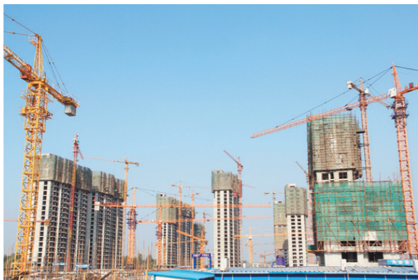
福民工程4号安置小区塔吊林立。
