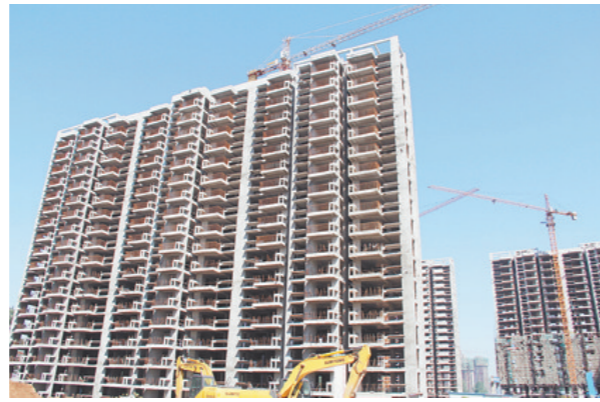
福民工程2号安置小区拔地而起。
