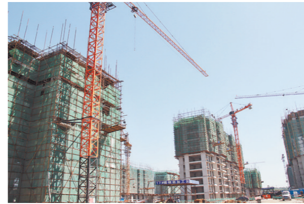
福民工程8号安置小区紧张施工。
