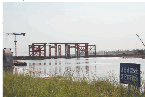
开拓大道橡胶坝,水深5米且河底沙坑较多。
