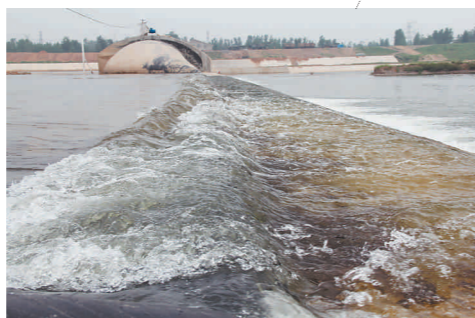
伊洛大道附近橡胶坝,水流湍急,水深5米。
