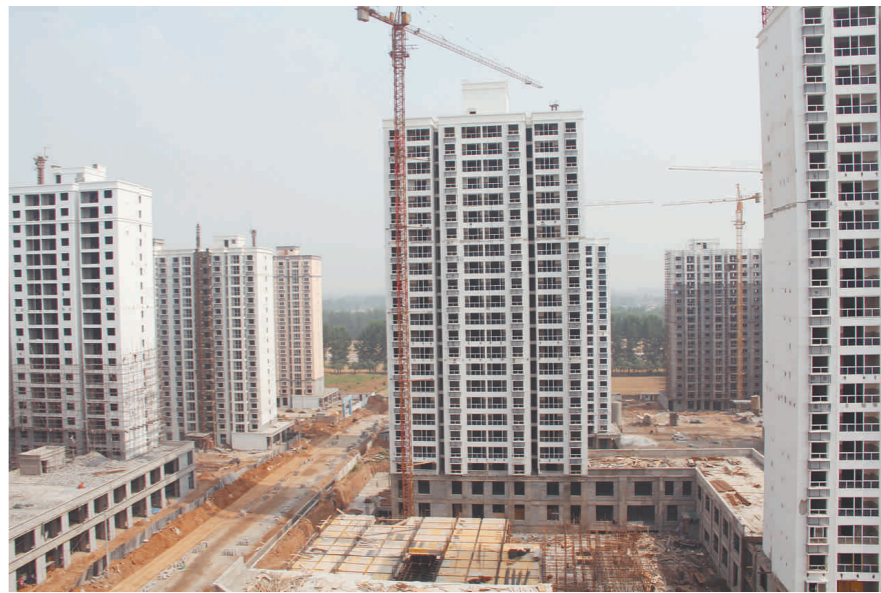
福民工程1号安置小区室外配套工程即将完工。 阮现武 摄
