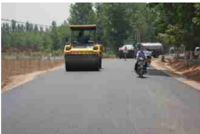
掘丁路庞村镇段综合提升工程北起洛偃快速通道,南至庞村、寇店两镇交界,全长4.3公里。图为施工场面。刘朝峰 摄
