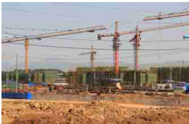
8号福民安置小区位于李村镇南寨村,占地276亩,规划建设高层建筑24栋,36班小学一所,12班幼儿园一所,并规划有融合居委会、文化活动、医疗等功能为一体的社区服务中心及沿街商铺。图为正在施工的8号小区。阮现武 摄
